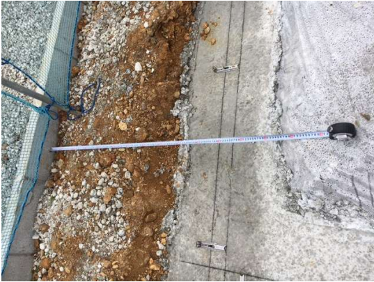
建物北西 墨打ち追い出し確認① 境界～壁芯：1,150 CB～壁芯：1,100 配置図、基礎図との照合→OK
