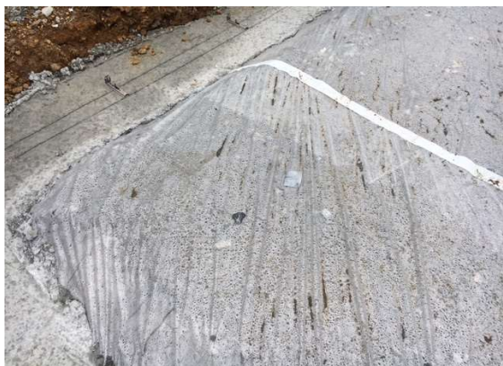
破れ部 防水テープ処理
