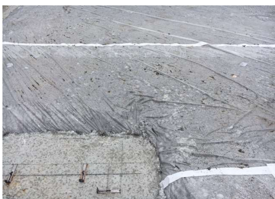
破れ部 防水テープ処理
