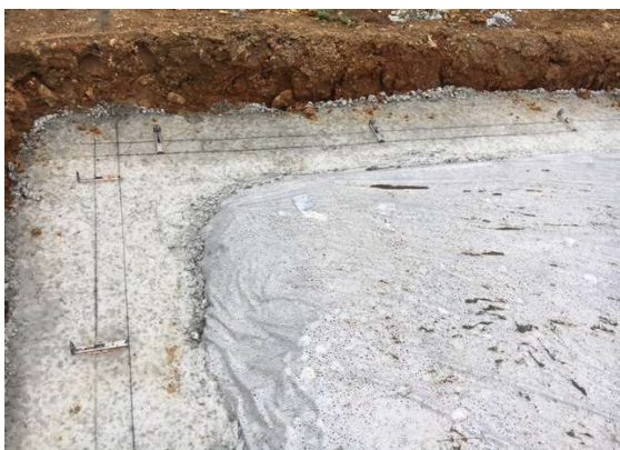
破れ部 防水テープ処理
