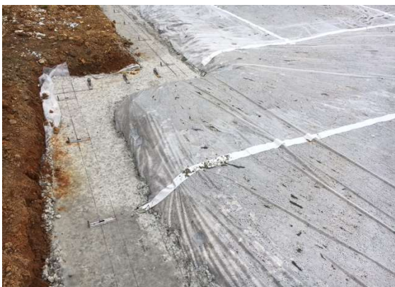
破れ部 防水テープ処理
