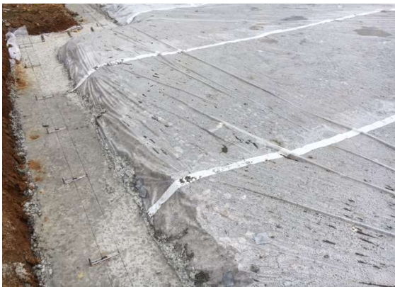
破れ部 防水テープ処理
