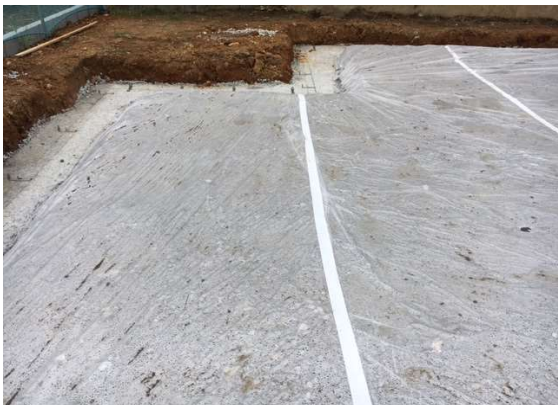
破れ部 防水テープ処理
