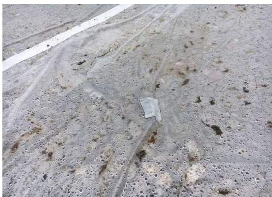
破れ部 防水テープ処理
