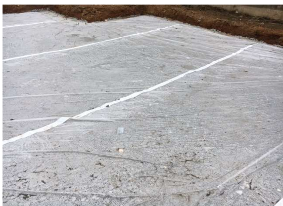
破れ部 防水テープ処理
