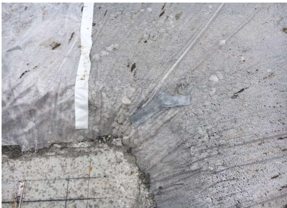
破れ部 防水テープ処理
