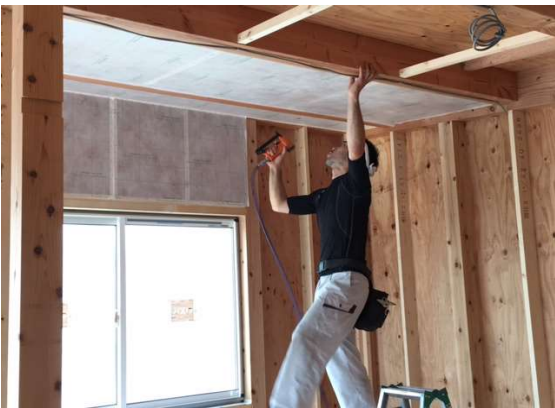
シート張り状況
