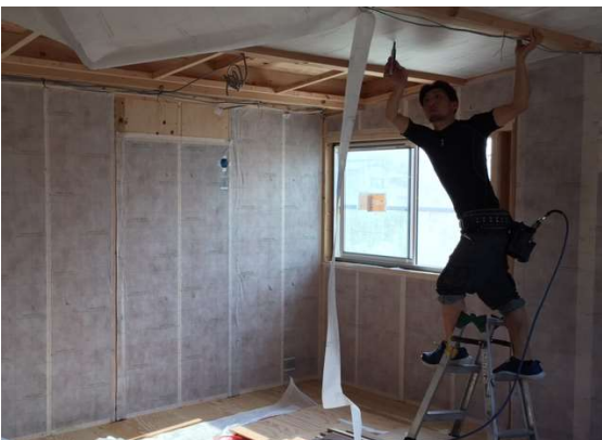
シート張り状況
