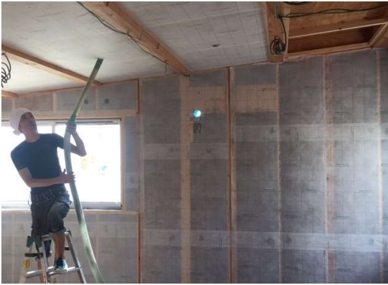
吹き込み状況
