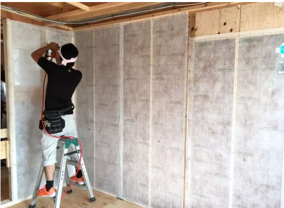
シート張り状況
