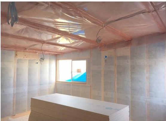
子供室 シート張り
