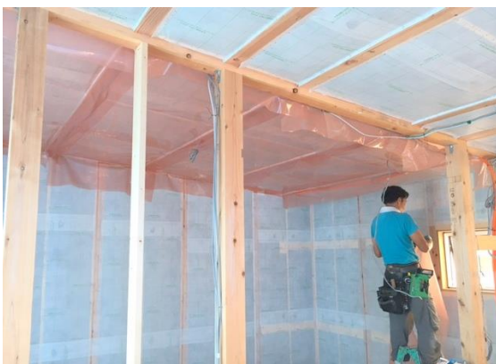
寝室 シート張り
