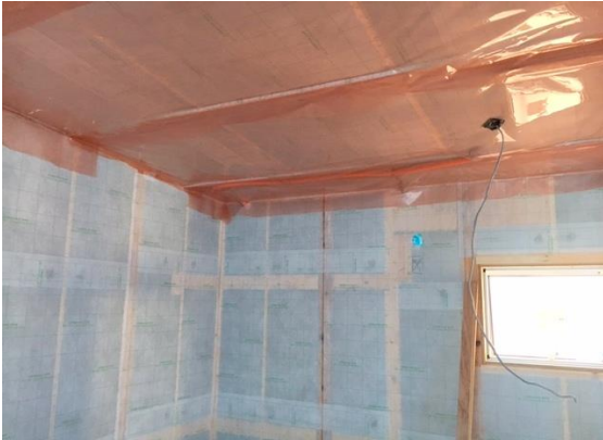
寝室 シート張り
