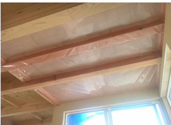
1階 バルコニー下 シート張り
