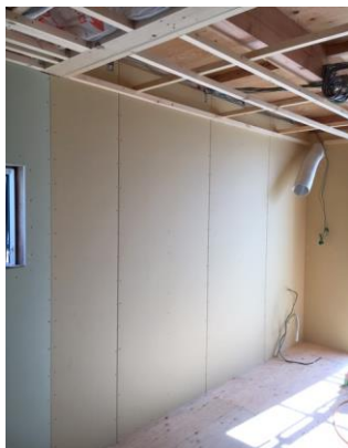
1階 壁ボード施工状況
