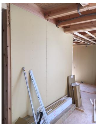
1階 壁ボード施工状況
